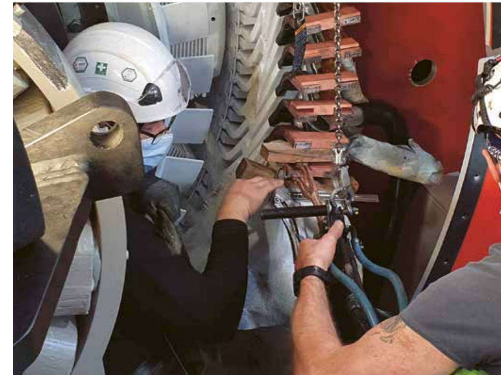
Bei der Modernisierung des Wasserkraftwerks Mottec, welche die Jahresproduktion um 5 Millionen kWh steigern soll, werden zwei der drei Maschinengruppen (Schieber, Turbinen, Generatoren und Transformatoren) komplett ersetzt.
