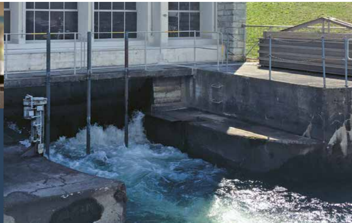
Sondes de température dans le canal de fuite d'un groupe Francis. Temperatursonden im Auslaufkanal einer Francis-Turbine.
