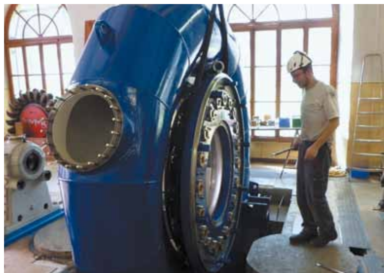
Travaux de réhabilitation à la Centrale de Martigny-Bourg. Rehabilitierungsarbeiten in der Zentrale Martigny-Bourg.
