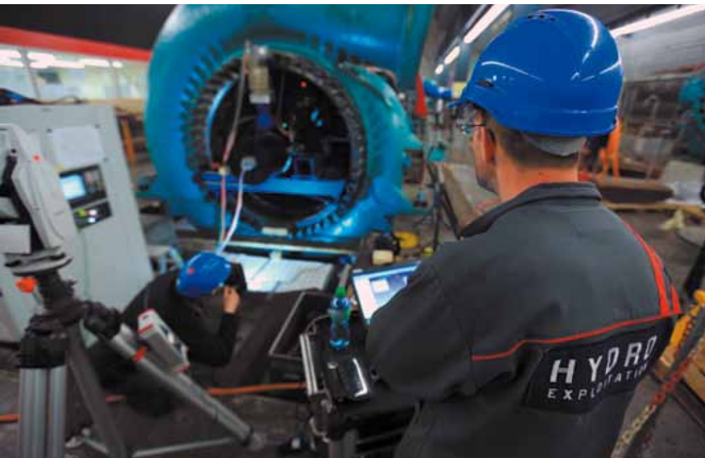
Réhabilitation du groupe 2, Veytaux Rehabilitierung der Gruppe 2, Veytaux
